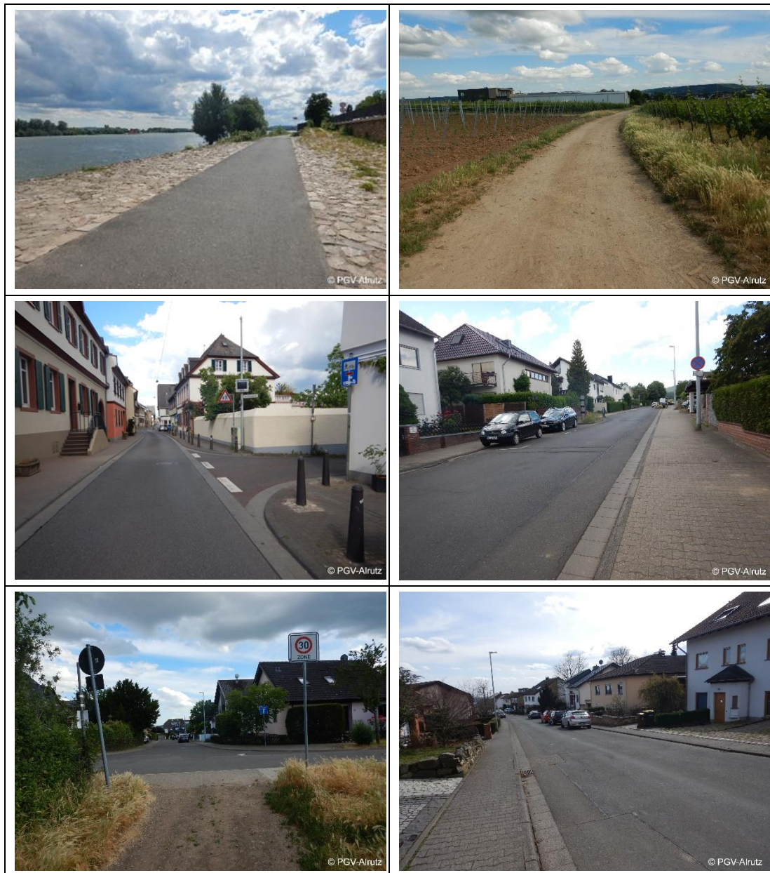
Abb. 3-1: Radverkehrsführung im Zuge Leinpfad und R3A (oben), Mischverkehrsführung bei hohen Kfz-Stärken im Zuge der B 42a (Winkel) (Mitte links) und der Schillerstraße (K 631) (Mitte rechts) und verträglicher Mischverkehr in Winkel (unten links) und Hallgarten (unten rechts)
